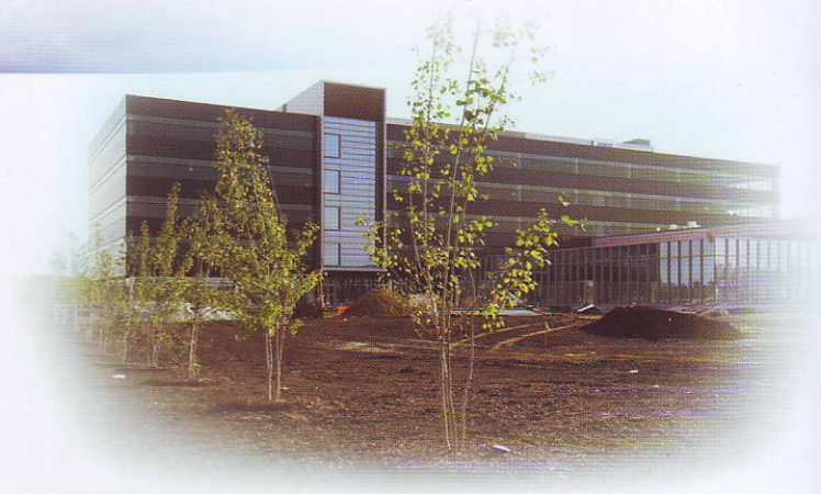
正在修建的泛达全球总部
