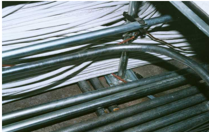
图 2 部署在地板下的硬管配电图示
